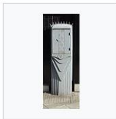
Elektrische verdeelkast (Kabelkast Model G) van de voormalige Gemeente- Electriciteitswerken
